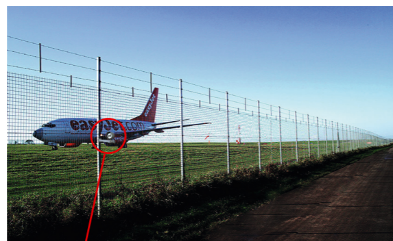
Двухпозиционный радиоволновой извещатель «Призма-3-24». Охрана периметра аэродрома вдоль полотна сетчатого заграждения
